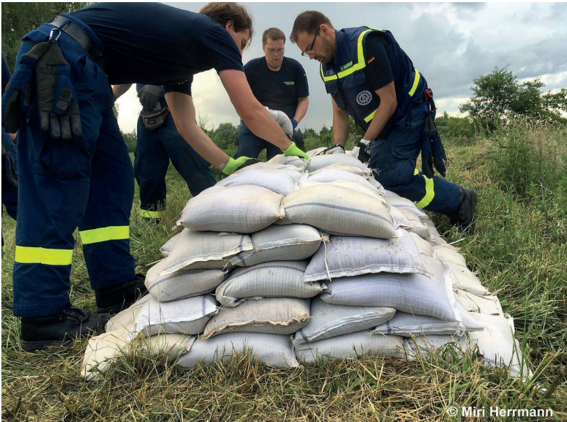
Abb. 55: Sandsackverlegung nach System
