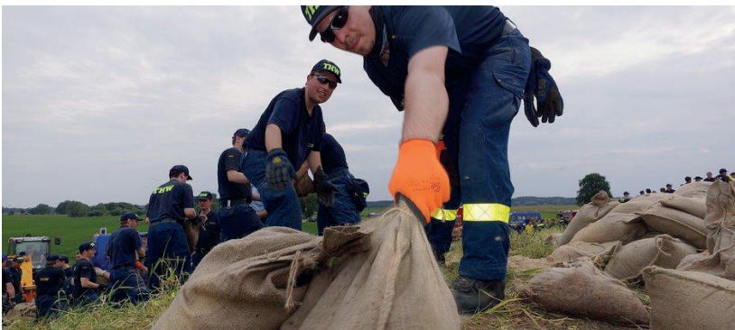
Abb. 50: Transportkette durch Einsatzkräfte
