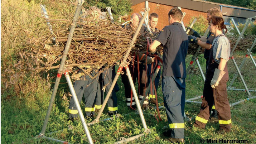
Abb. 63: Faschine – Aufbau
