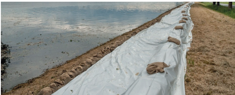
Abb. 52: Sandsackdamm (Aufkadung mit Folie)
