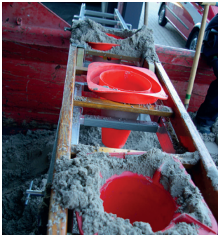
Abb. 45: Abgeschnittener Verkehrsleitkegel als Trichter
